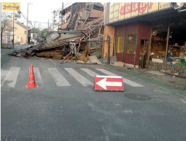
熊本市における住家の被害状況 (岡山市消防局提供)
