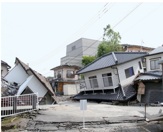
倒壊家屋の様子（益城町消防団提供）
