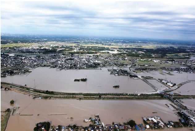
常総市における被害状況 (茨城県提供)
